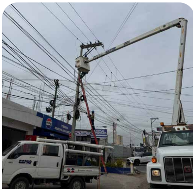
Técnicos de la Empresa Eléctrica Municipal de Quetzaltenango realizaron este jueves 22 de octubre reparaciones en la diagonal 3 y 9.ª calle, zona 8. 📷 EEMQ
