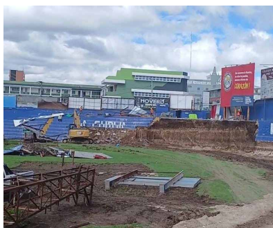
La Curva fue demolida hoy. 📷 LA VOZ DE XELA
