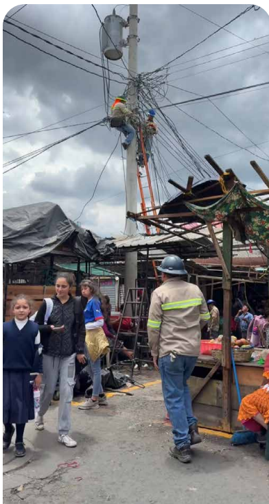
Personal de la EEMQ continúa trabajando en postes de la zona 3 para concluir el proyecto de ampliación de la red de media tensión.
